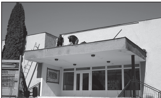
Oprava strechy nad schodišťom kultúrneho domu
