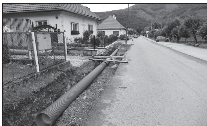
Výmena dažďovej kanalizácie na Ul. kaštieľnej
